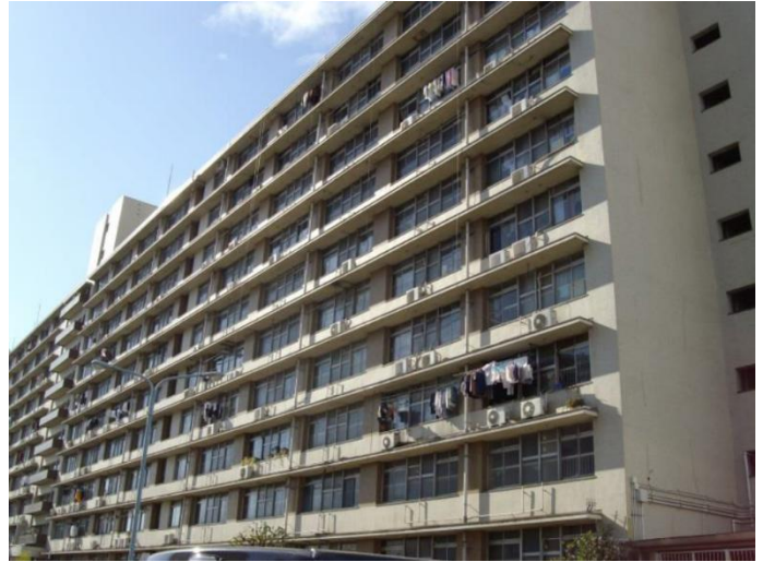
補強前の建物外観
