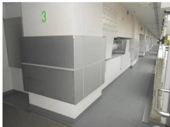
3階廊下側完成状況
