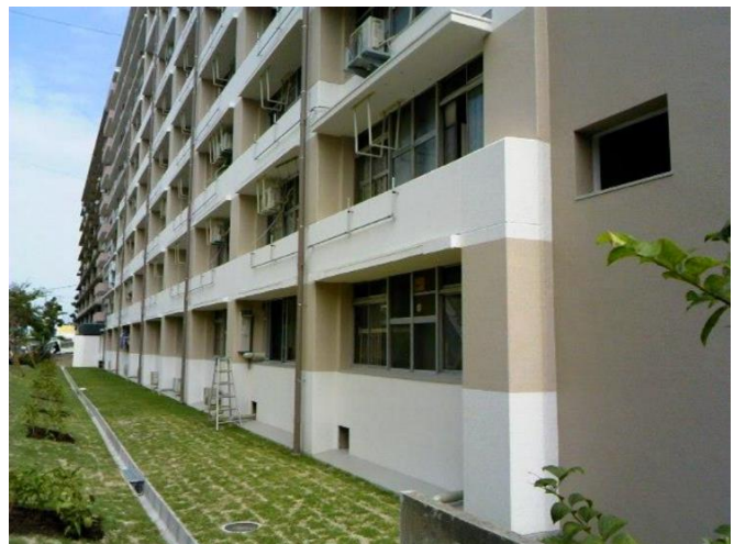
補強後の建物外観
