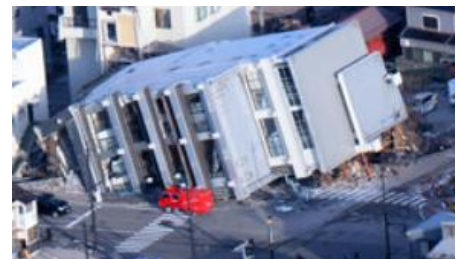
能登半島・杭の耐震性不足で倒壊
