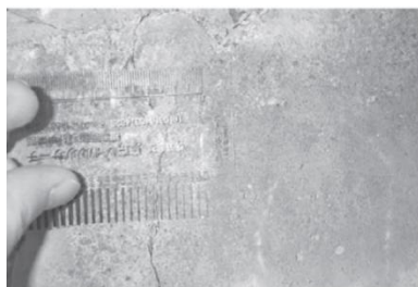
ひび割れ調査
