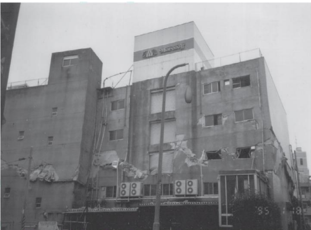
④中間層崩壊（1995兵庫県南部地震）：旧基準法で設計された建物の中間層1階部分が完全に崩壊しています。
