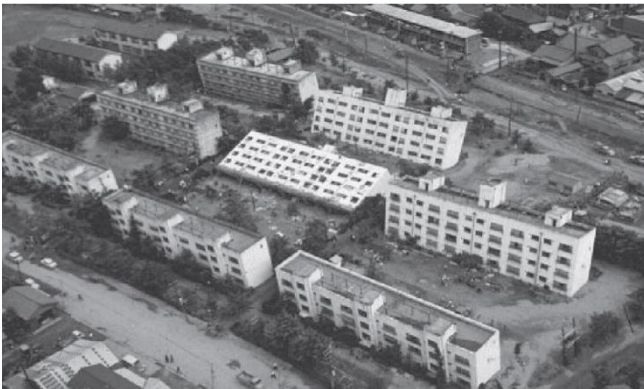
②液状化によるアパートの転倒（1964新潟地震）：水を含んだ砂地盤が液状化し、アパートが転倒する被害が生じました
