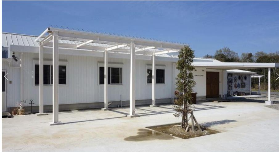
G邸:鉄骨造にCLTを外壁として使った
