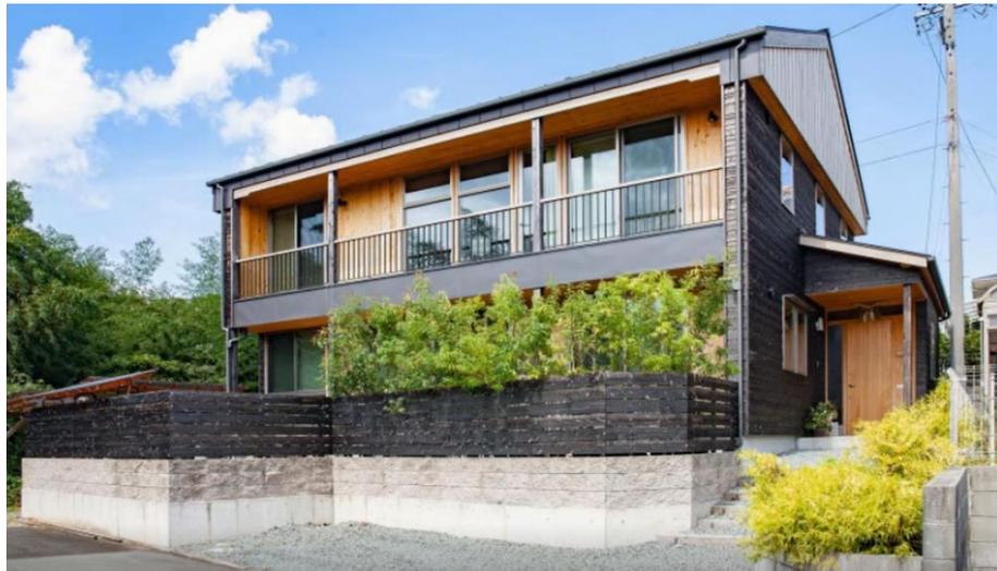
U邸:在来軸組木造でCLTを壁に組み込んだ戸建住宅
