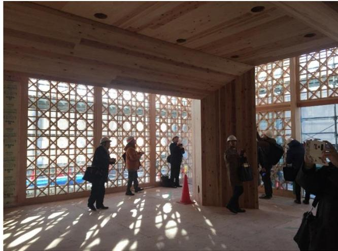
吹抜空間への組子耐力壁の採用により、より印象的な空間を実現している
