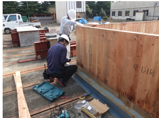
図 3.19 壁は土台に斜めビス打ちで固定
