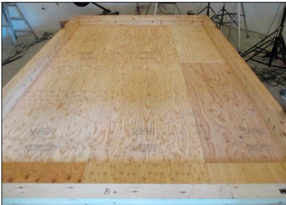
(3) 試験体No.0-2の設置状況
