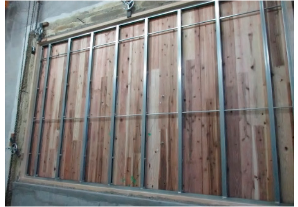
(2)LGSの取付状況
