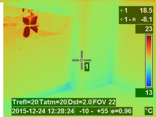
図 4. 2. 1-31 室内⑨ 3階キッチン西サーモ画像
