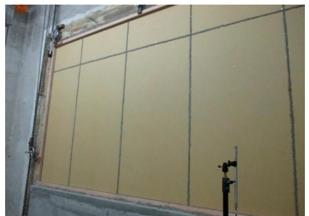
(6)下張りPB(12.5mm)の設置状況
