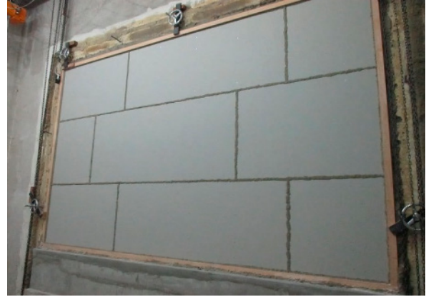
(4) 上張り硬質PB(9.5mm)の設置状況
