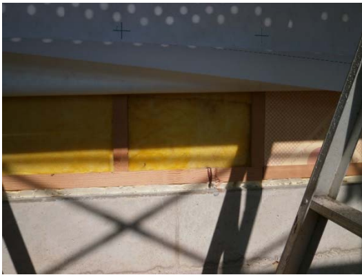
図 4.2.3-6 1 部 (断熱材復元)
