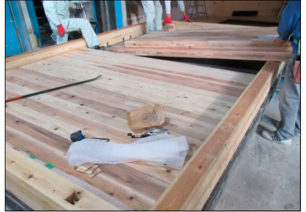
(2) 天井CLTパネル(t=90)の搬入
