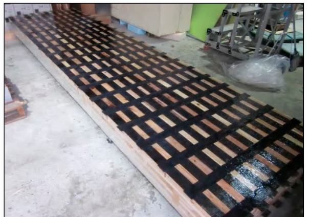
(6) 試験体No.4-2の設置状況
