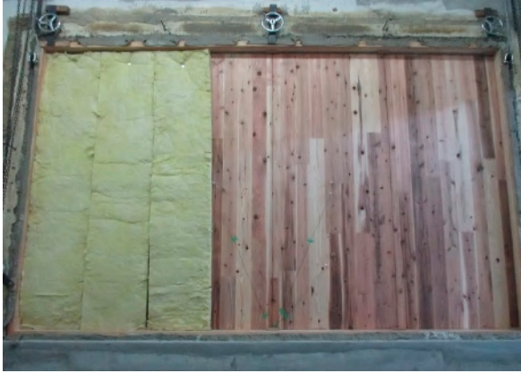
(1)GWの施工状況
