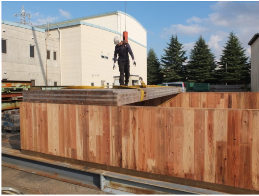
図 3.22 CLT 床版 (5.5m×2m) 1 枚目を壁に載せる
