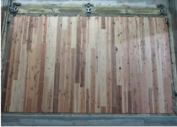
(3)CLTパネル(t=90mm)の設置状況
