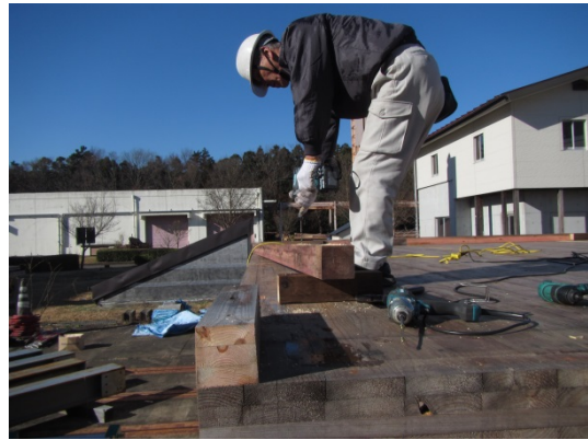
図 3.25 404 材を CLT 床版にビス留め
