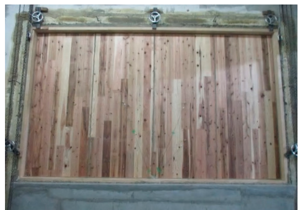
(6) CLTパネル(t=150mm)4枚の設置状況
