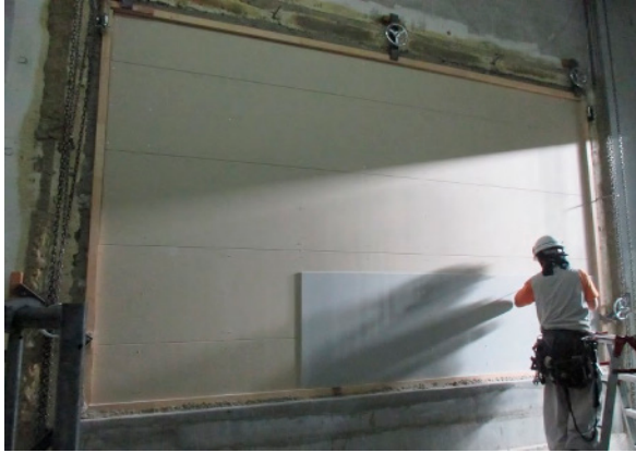
(3) 上張り硬質PB(9.5mm)の施工状況
