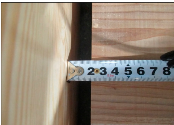
(5) 下階側の四周空気抜きの様子(試験体No.1-3)
