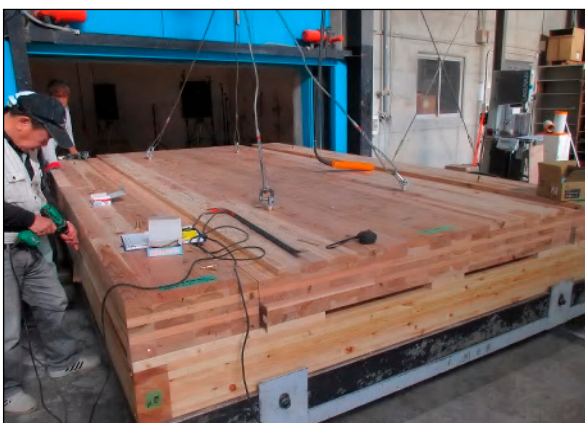
(5) 床CLTパネル(t=210)の設置
