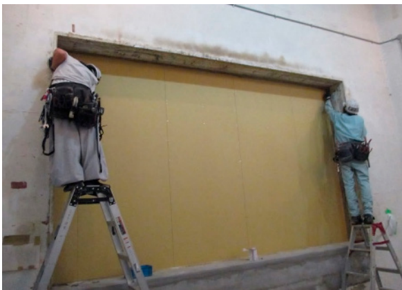
(5) 下張りPB(12.5mm)の設置状況 (音源側)
