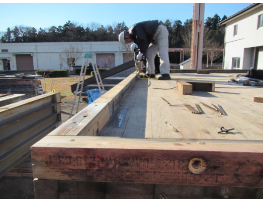
図 3.50 森林総研+ \alpha モデル：404材を ビス留め
