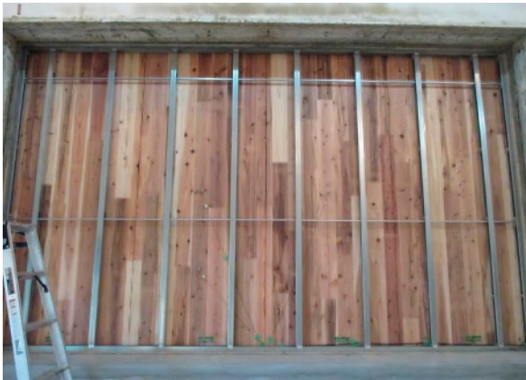
(3) LGSの取付状況(音源側)
