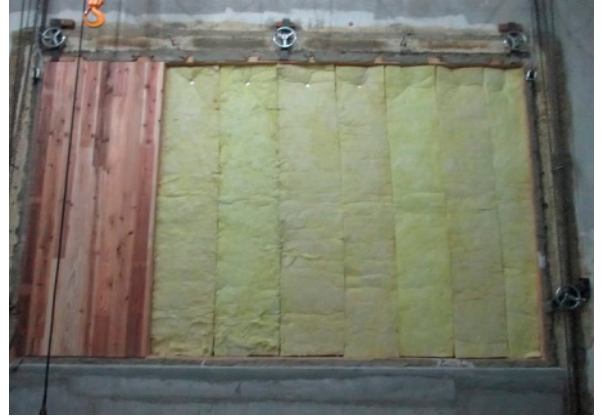
(2)GWの設置状況とCLTパネル(t=90mm)の施工状況
