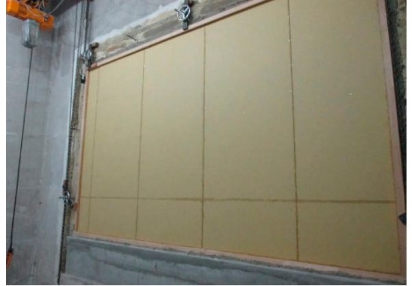
(2) 上張りPB(9.5mm)の設置状況
