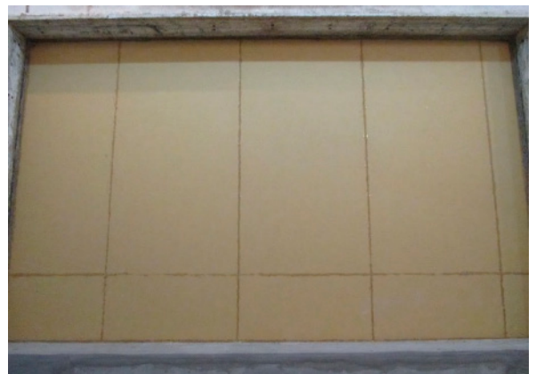
(6) 上張りPB(9.5mm)の設置状況 (音源側)
