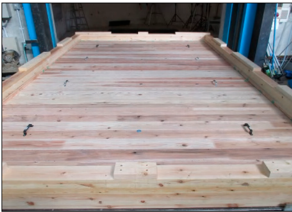
(3) 天井CLTパネル(t=90)の設置
