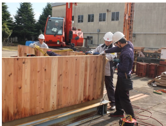
図 3.20 壁のコーナー部分はビス平打ち
