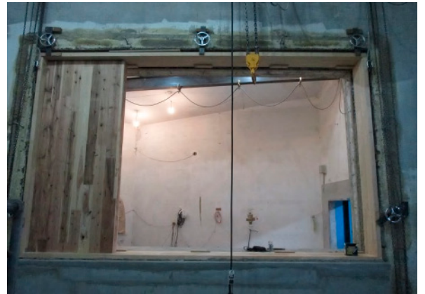
(4) CLTパネル(t=150mm)の取付状況
