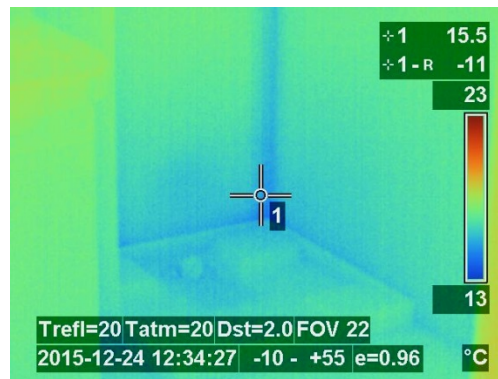
図 4. 2. 1-39 室内⑬ 3階寢洗面室北サーモ画像
