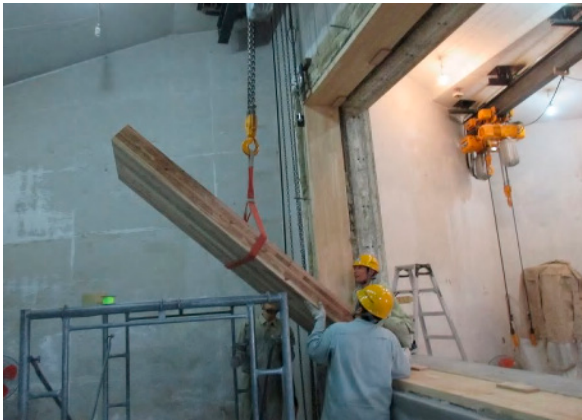
(3) CLTパネル(t=150mm)の取付状況
