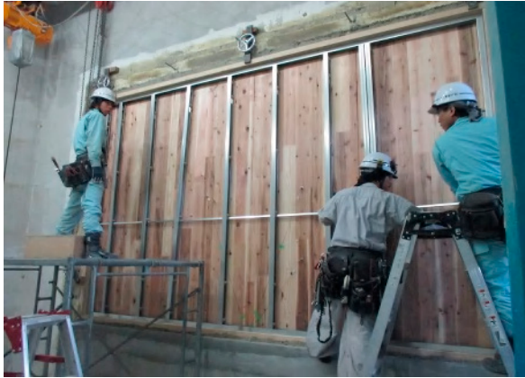
(1)LGSの施工状況
