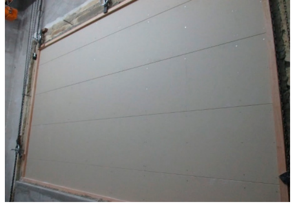
(2) 下張り強化PB(21mm)の設置状況
