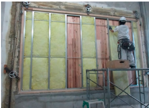
(3)GWの施工状況
