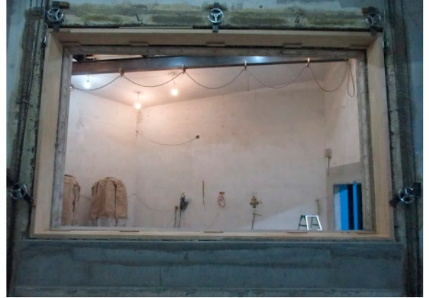
(2) 四周木枠の取付状況
