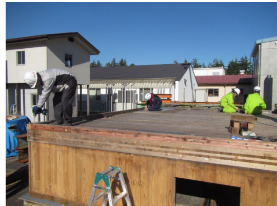
図 3.37 404 材と L 形金物を外す
