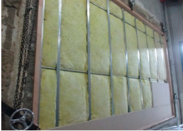
(1) 下張り強化PB(21mm)の施工状況
