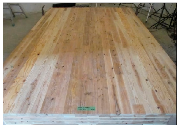
(6) 床CLTパネル(t=210)の設置状況
