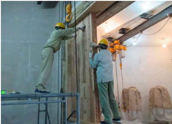
(3) CLTパネル(t=150mm)の取付状況
