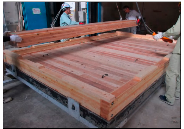
(4) 床CLTパネル(t=210)の搬入
