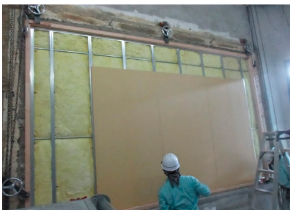
(5)下張りPB(12.5mm)の施工状況
