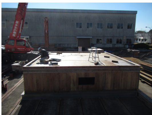
図 3.26 北見モデル : L 形金物を 404 材と CLT 床版にビス留め
