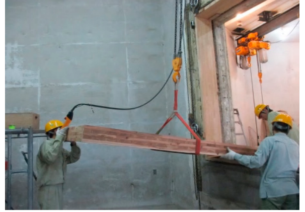
(2) CLTパネル(t=150mm)の取付状況
