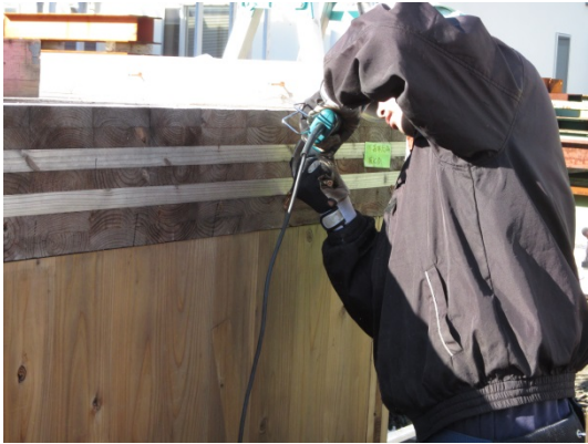
図 3.48 森林総研+ \alpha モデル：床から 壁へ斜めビス留め
