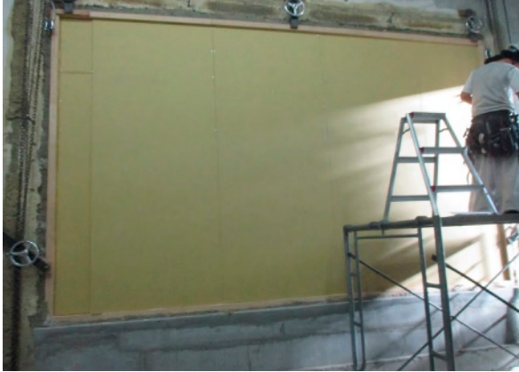
(1) 上張りPB(9.5mm)の施工状況
