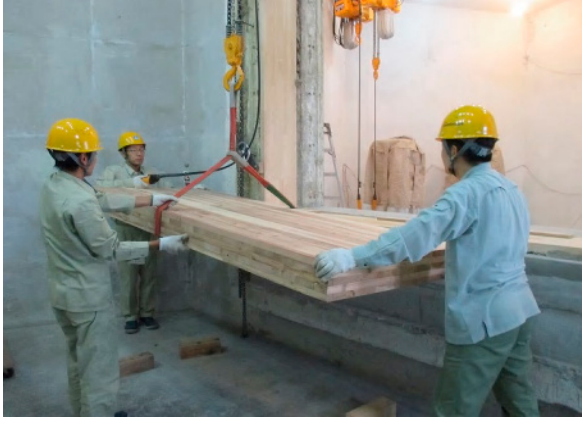
(1) CLTパネル(t=150mm)の取付状況
