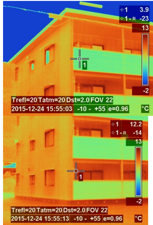
図 4.2.1-7 外観①（南西面）サーモ画像
