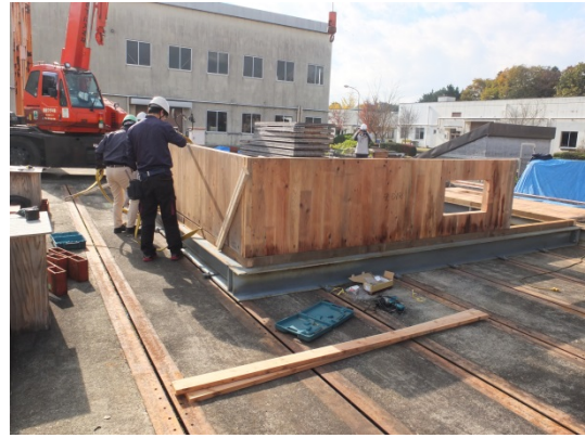
図 3.17 CLT 壁 (CLT、3層3プライ)
