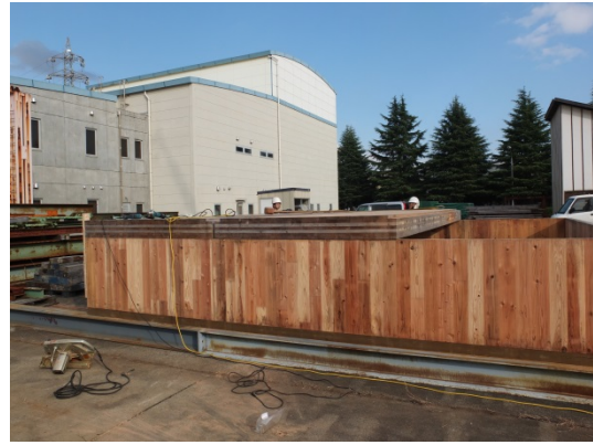
図 3.23 CLT 床版 (5.5m×2m) 2 枚目を壁に載せる
