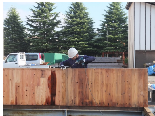
図 3.21 CLT 壁どうしの接合はビス斜め打ち
