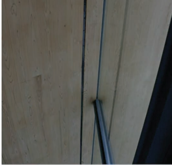
現場で加工したカーテンレールの溝
