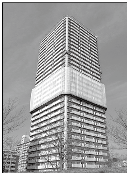
超高層マンション設置例 4面同時施工。垂直移送
