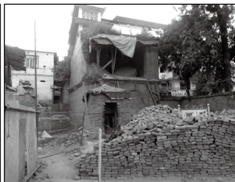
カトマンズ旧王宮裏道の民家、日干し煉瓦が集積されている
