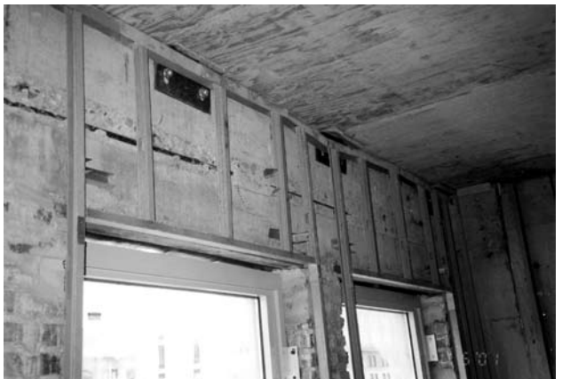
⑦周壁の内装断熱施工中の状況
