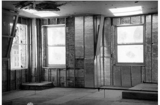
⑦周壁の内装断熱施工中の状況
