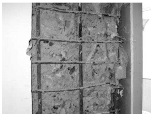
写真2 「三井物産横浜ビル」の鉄筋
