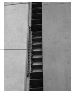
既存躯体とロッキング壁の間に介在させ、抵抗力と減衰効果を付加させる鋼材ダンパー
