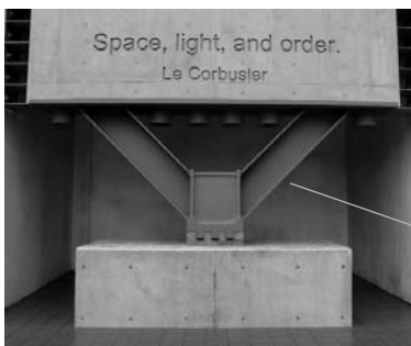
水平力のみを伝達する柱脚部のピン機構
